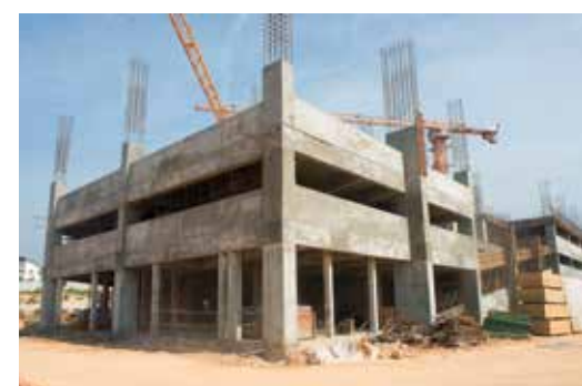
Pembangunan podium tempat letak kereta di PR1MA @ Alam Damai
