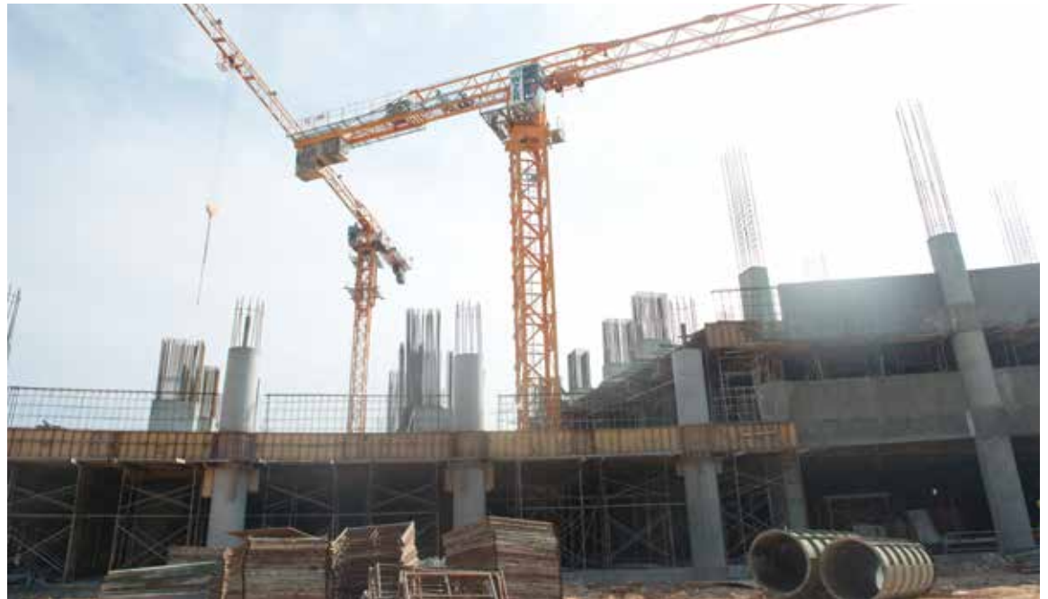
Pembangunan podium tempat letak kereta di PRIMA @ Alam Damai
