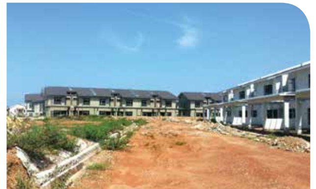
Pembangunan sedang dijalankan di PRIMA @ Kuala Ketil
